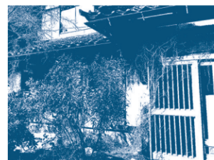
危険な放置空き家
