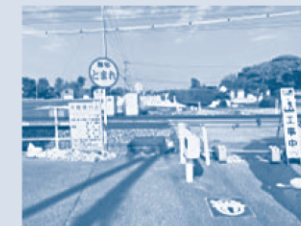
新村踏切の拡幅
